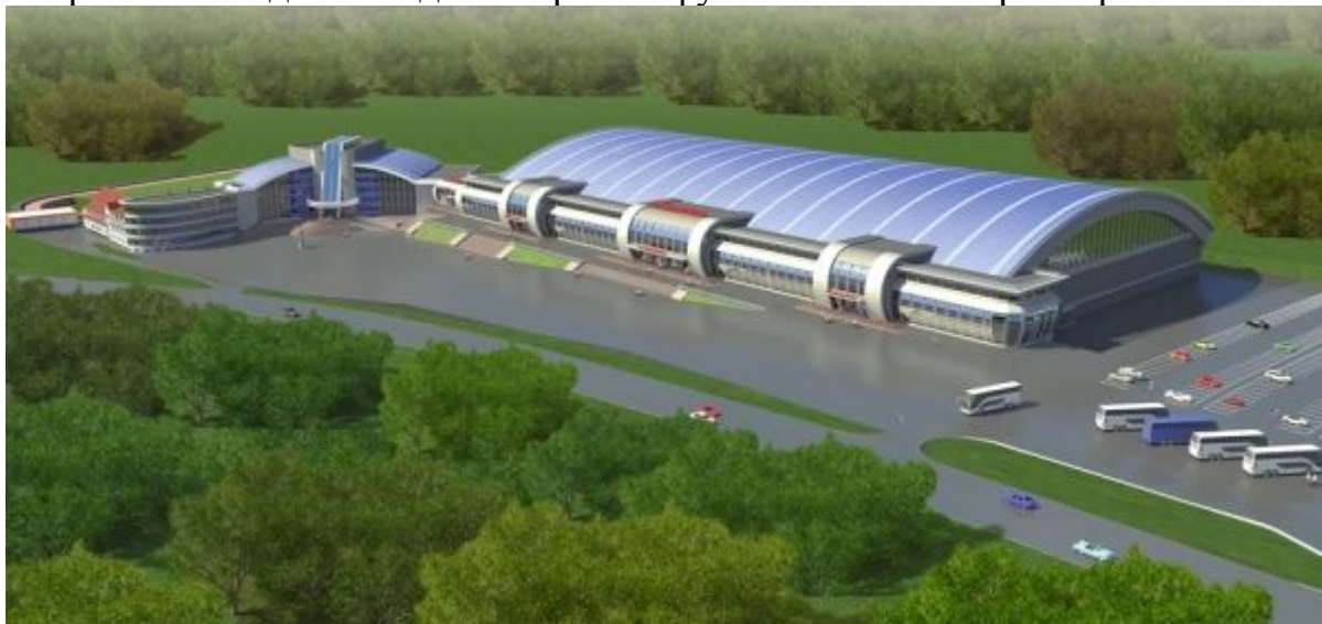
Рис.39 Строящийся центр олимпийской подготовки в Саранске
