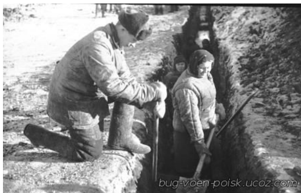
Газопровод «Бугуруслан - Куйбыше
