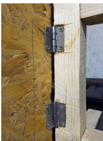
Рисунок 17. Крепление петли
