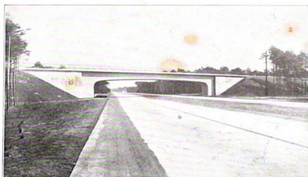
Reichsautobahn „Berliner Ring“ — Betondecke des XXVI mit Torbauwerk 302
