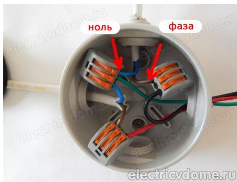
Рисунок 7 – Расположение проводов в распределительной коробке.
